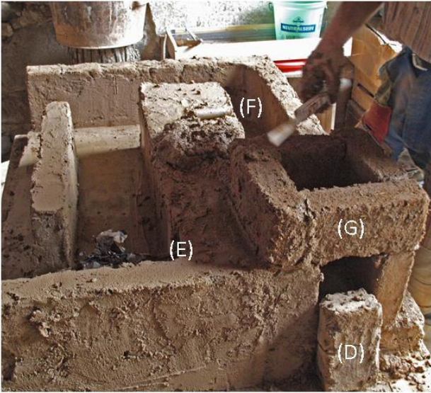
7: La base de la chimenea (Mod.1)
