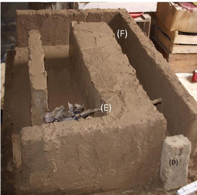
5: El fogón y el canal del humo (Mod.1)
