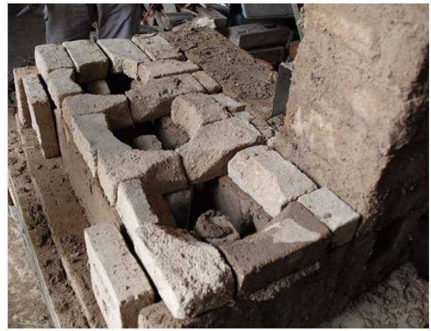
10: Tapadera del fogón con las hornallas (Mod.1)
