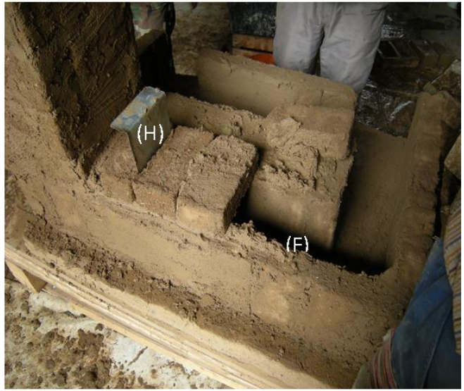
8: Tapadera del canal del humo y la chapa de la compuerta (Mod.1)
