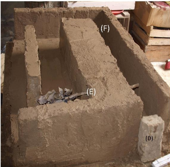
5: Gasschlitz (E) und Rauchkanal (F)
