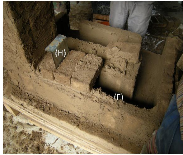
8: Abdeckung Rauchkanal; Schieber, Zugsperrerr (H) (Mod.1)
