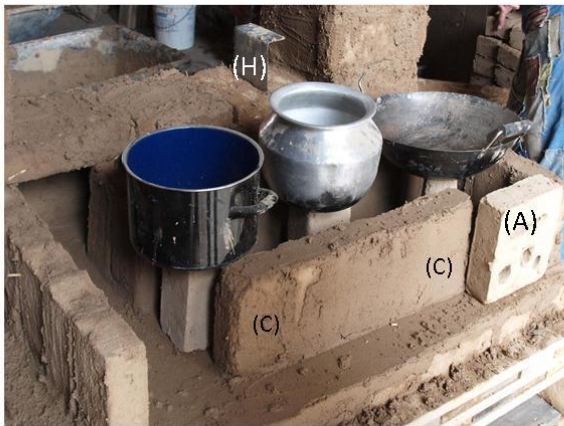
9: Bau Herdplatte mit Herdlöchern (Mod.1)
