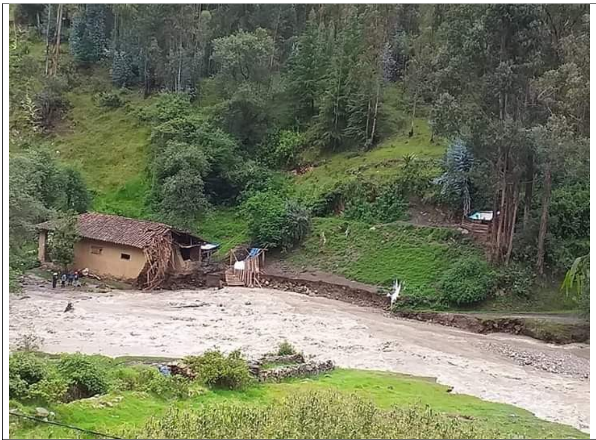
Cerca a la Planta eléctrica el río se ha llevado la carretera ahora a punto de caer la casa
