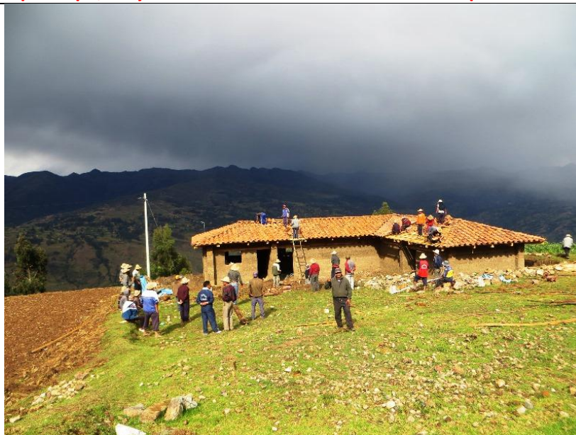
Terminando el techado, la comunidad trabajo en el traslado de las tejas y en el techado
