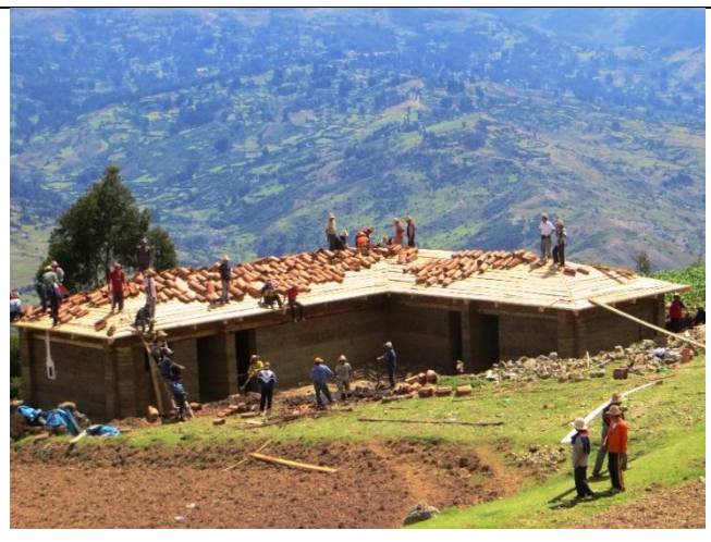
Preparando las tejas sobre el entablado
