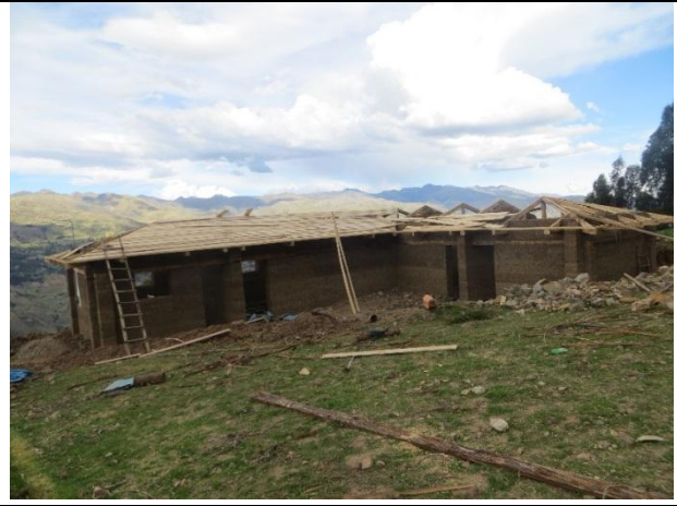
Culminando la base del techo
