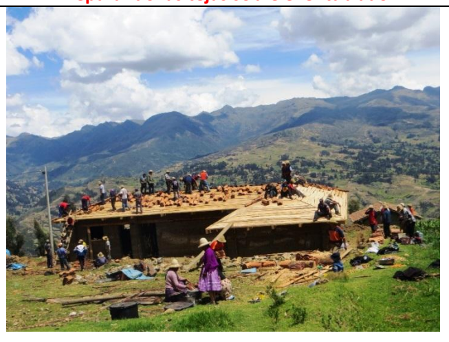
Inicio de colocación de tejas
