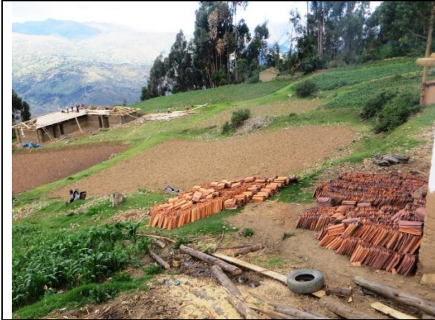
Tejas para el techo de la posta
